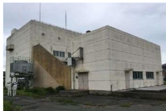
明神ポンプ場(機械・電気設備)
