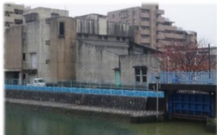
吹上ポンプ場(電気設備)
